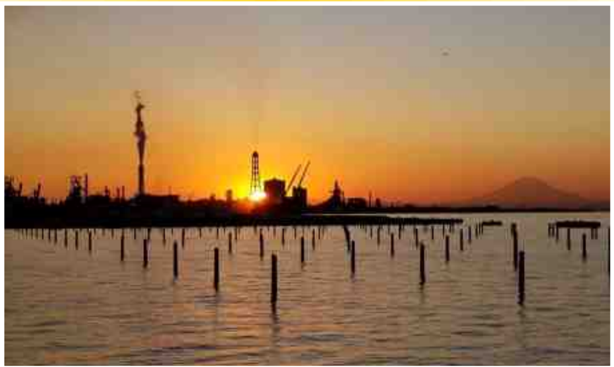
木更津南部地区 2号橋から木材港・H岸壁
