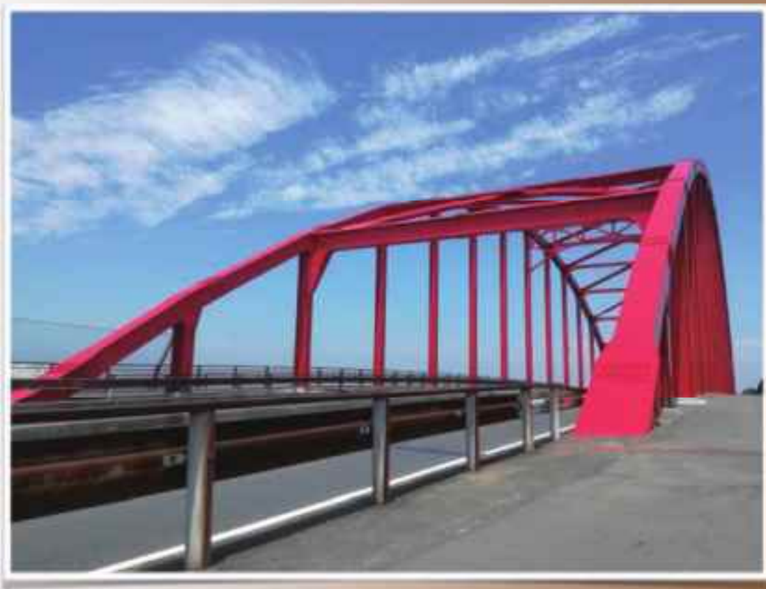
木更津南部地区 2号道路第2橋梁
