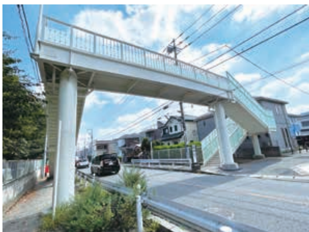
主要地方道 市川印西線 若宮3丁目歩道橋
