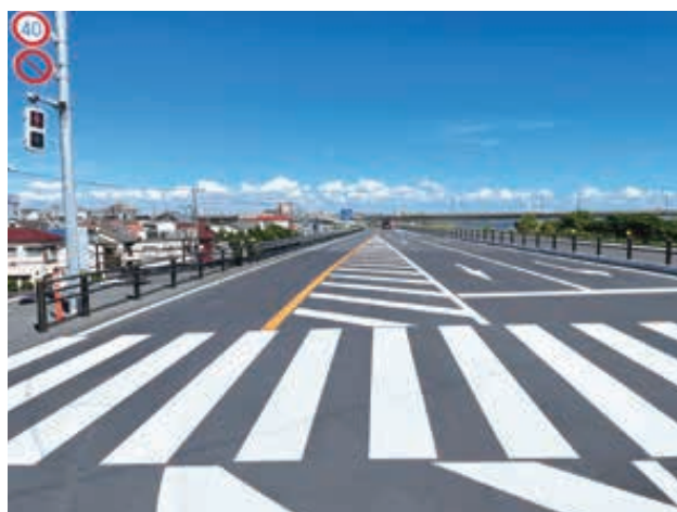
主要地方道 市川浦安線 市川市稲荷木2丁目
