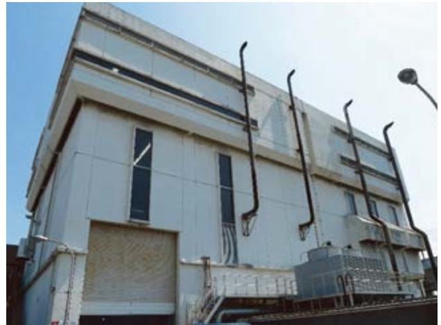
真間川排水機場 市川市原木地先
