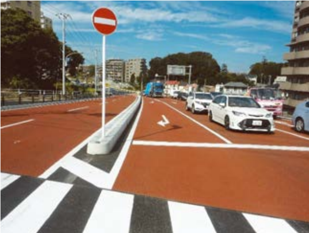
主要地方道 船橋我孫子線 船橋市東船橋3丁目地先
