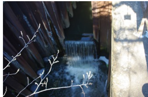
長津川上流区間にある落差工
