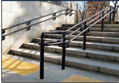
階段・スロープ手すり
