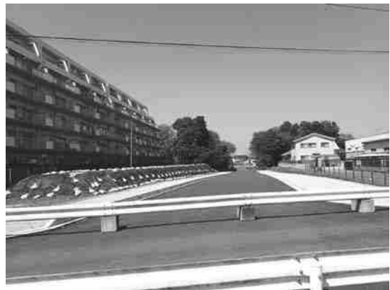
令和2年度施工 道路改良工 L=178m
