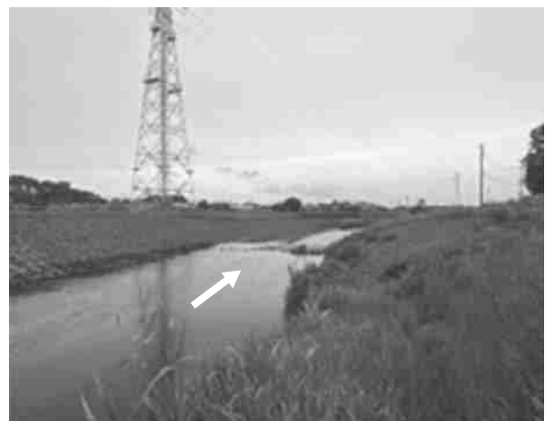
令和3年度完成 護岸工 L=50m(左岸)
