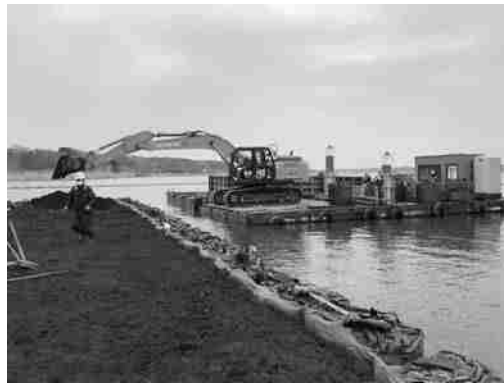
平成30年度施工 植生帯整備工 L=43.7m
