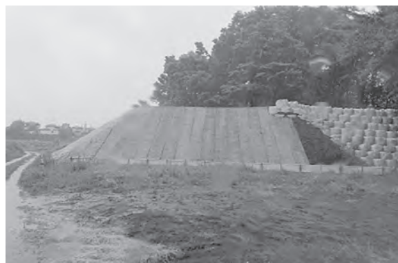
平成30年度施工 盛土工 V=4,300m 3
