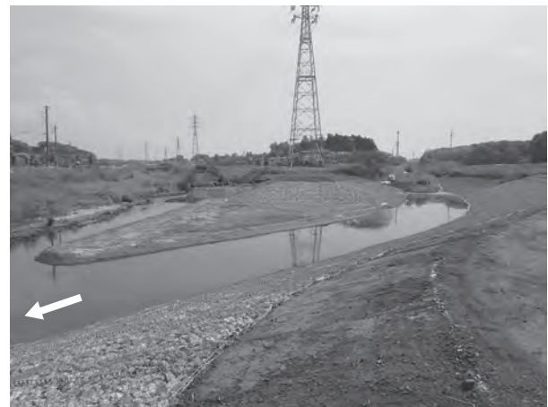
令和元年度完成 護岸工 A=1,276m 2 (合流部一体施工)
