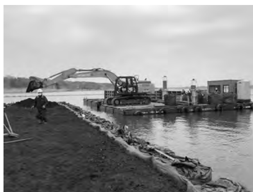
平成30年度施工 植生帯整備工 L=43.7m
