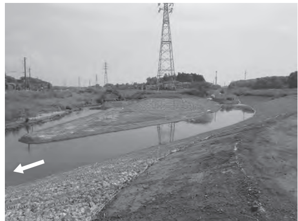
平成30年度施工 護岸工 A=1,276m 2 (合流部一体施工)
