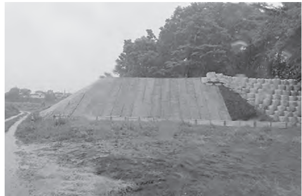
平成30年度施工 盛土工 V=4,300m 3
