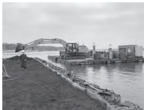
平成30年度施工 植生帯整備工 L=43.7m
