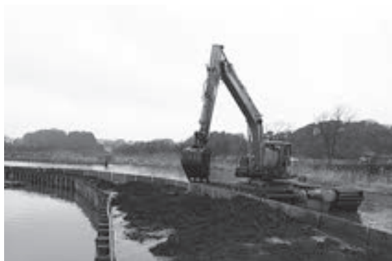
令和5年度施工 植生帯基盤整備工 L=120m
