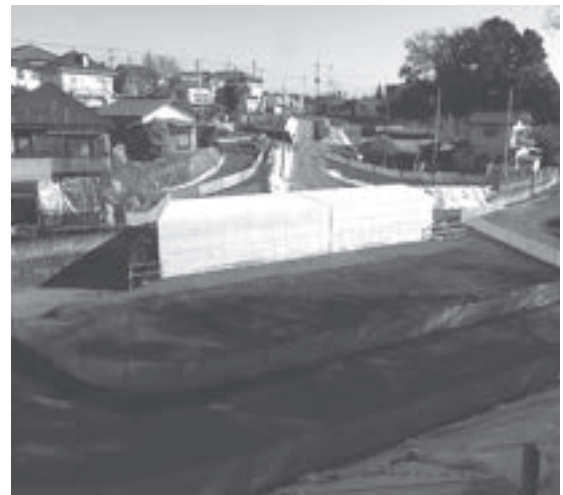
令和4年度施工 函渠工 1基
