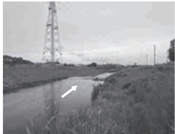
令和3年度完成 護岸工 L=50m(左岸)
