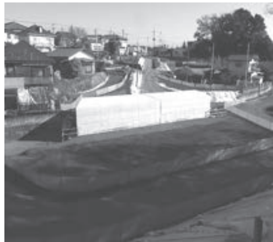
令和4年度施工 函渠工 1基
