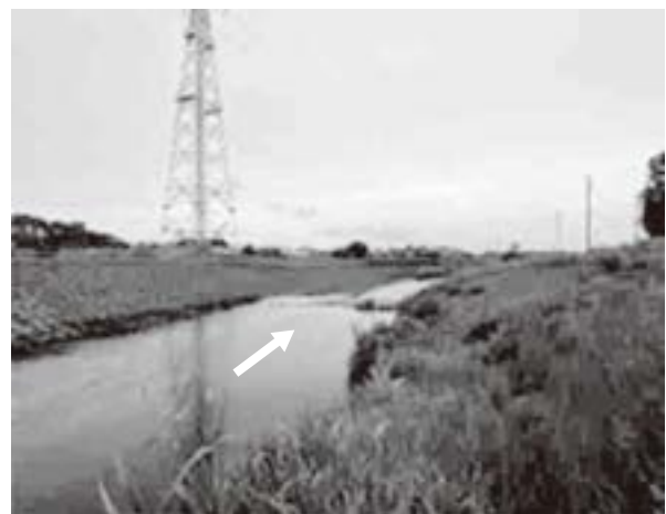
令和3年度完成 護岸工 L=50m(左岸)
