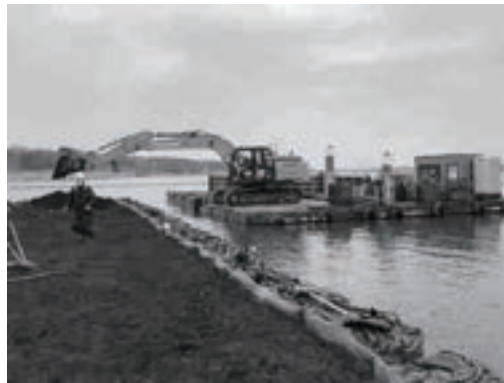
平成30年度施工 植生帯整備工 L=43.7m
