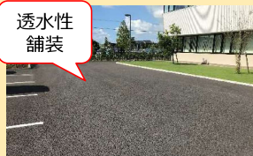
雨水貯留浸透施設（浸透）の事例
