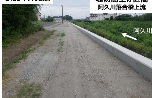
堤防嵩上げ区間 阿久川落合橋上流
