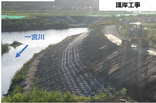
河道掘削区間 護岸工事
