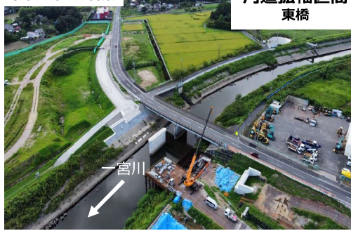
河道拡幅区間 東橋
