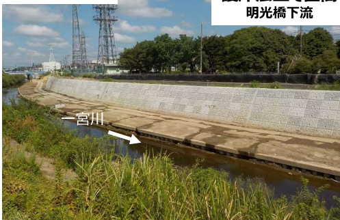
護岸法立て区間 明光橋下流
