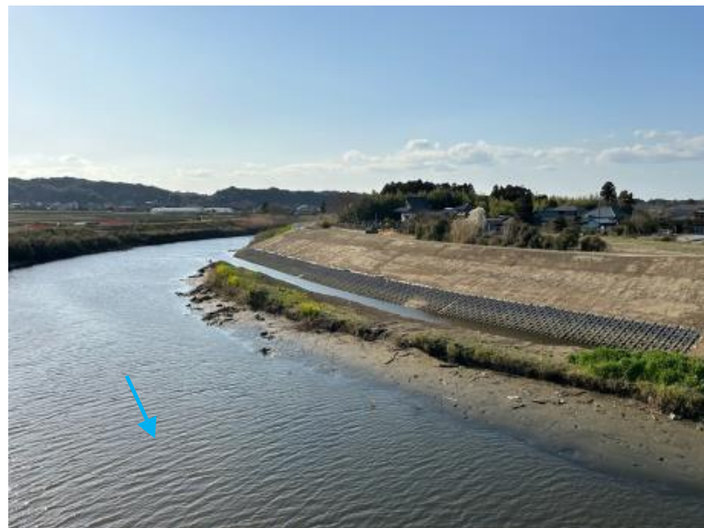
睦沢町川島地先 令和5年3月撮影
