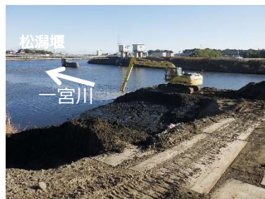
松渦堰上流の堆積土砂撤去の状況 (令和4年12月撮影)
