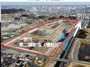
第二調節池の掘削状況 (令和5年3月撮影)
