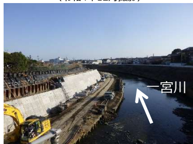
茂原市街地の護岸法立て工事の状況 (令和5年3月撮影)
