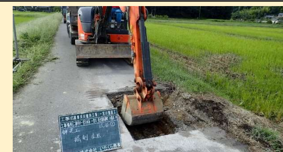
事前試掘（埋設物の位置の確認）
