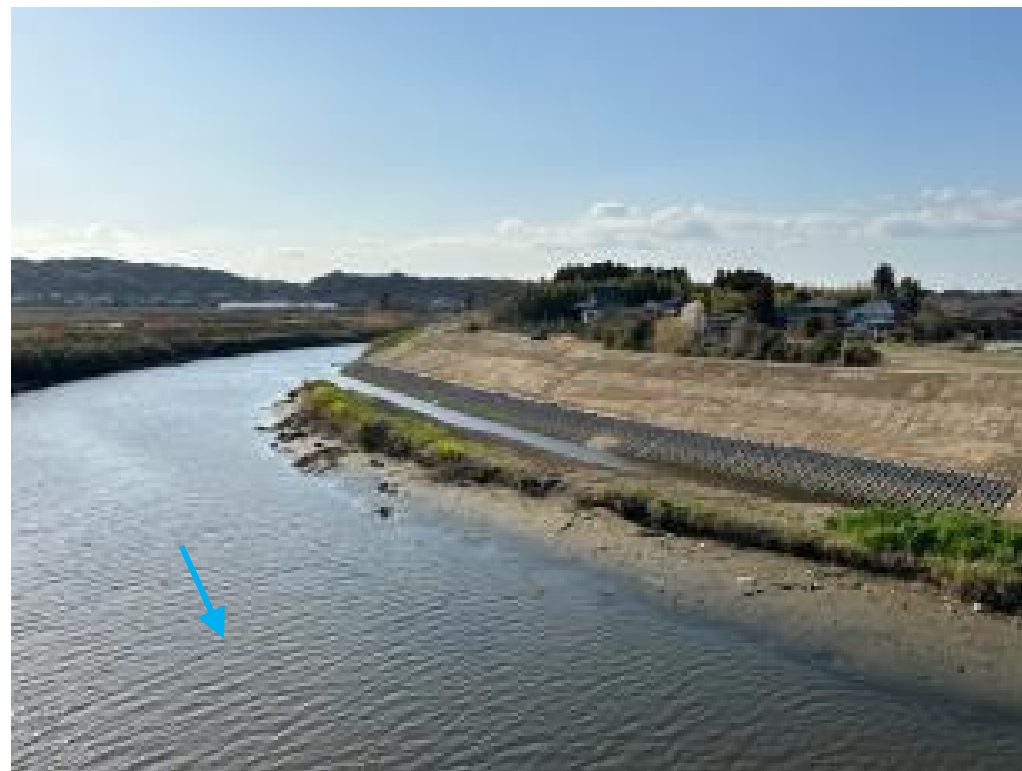
睦沢町川島地先 令和5年3月撮影
