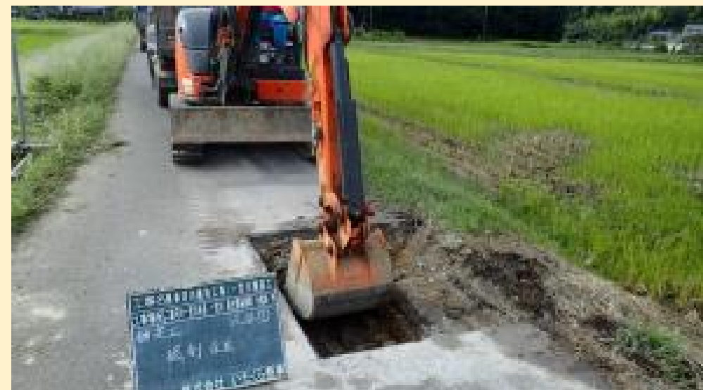
事前試掘 (埋設物の位置の確認)
