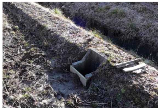
①柴名・上太田環境保全対策協議会
