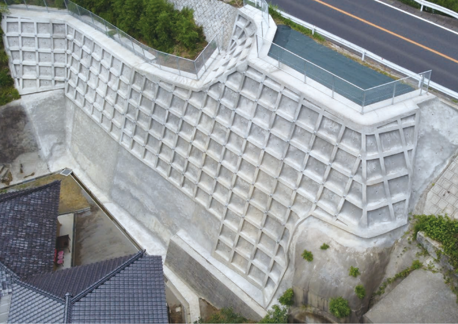
急傾斜地崩壊危険区域(小食土町)
