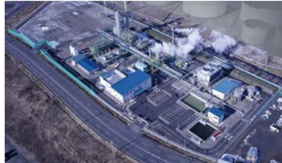
苫小牧CCS実証試験センター
