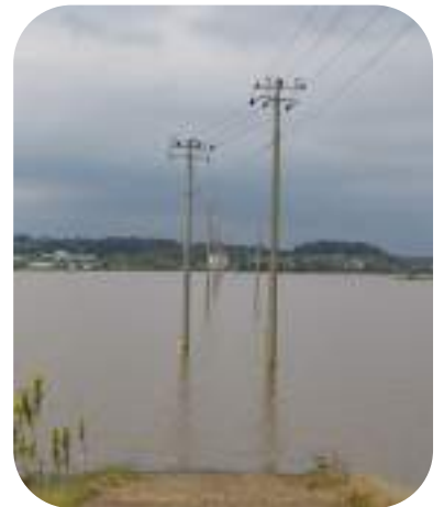
大雨により水位が上がった河川
