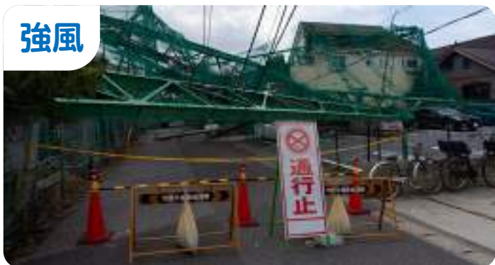
強風により飛ばされた鉄柱
