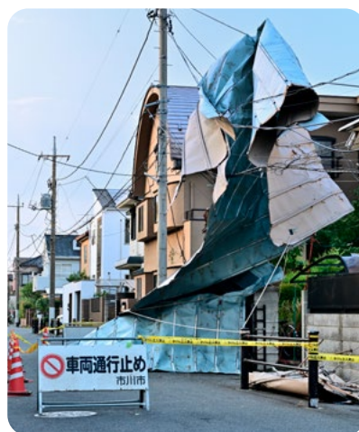
飛ばされたトタン屋根
