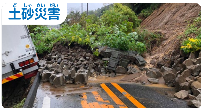
大雨によりくずれたしゃ面
