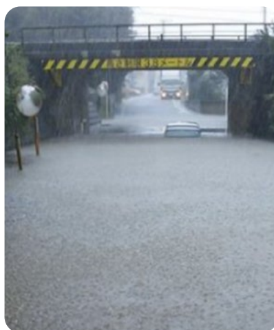
水がたまったアンダーパス 提供：千葉国道事務所
