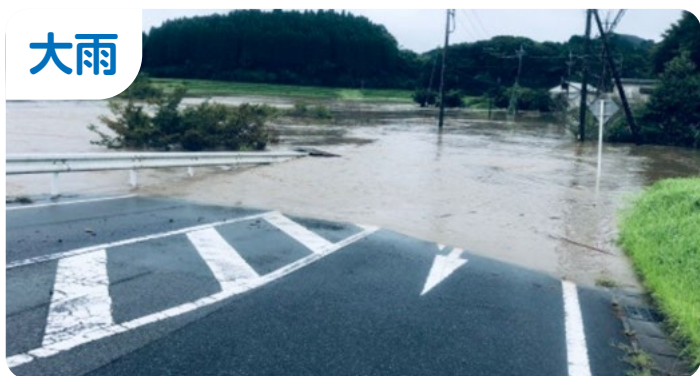
道路にあふれた雨水
