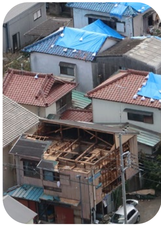
強い風で飛ばされた屋根
