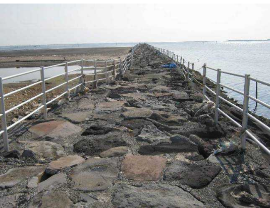
写真 2-1-34(101 ページ) 防波堤の被害 (ふなばし三番瀬海浜公園：環境生活部提供)
