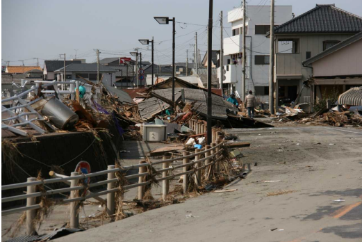
写真 2-2-23 (109 ページ) 津波による被害 (旭市飯岡地域：旭市提供)
