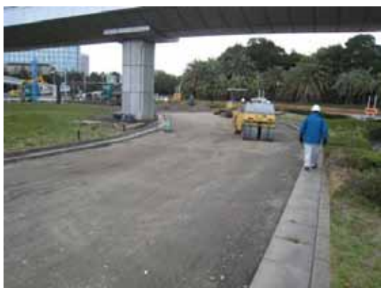
写真 3-12-15 応急仮復旧工事状況
