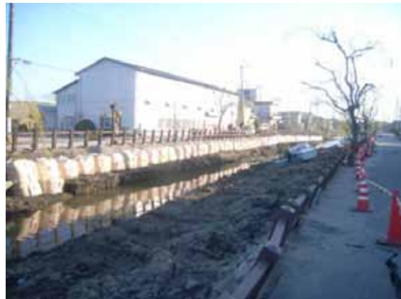
応急仮工事 大型土のう設置
