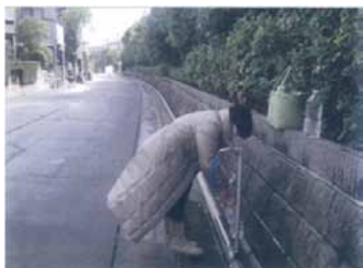
写真 3-11-5 仮配管敷設状況
