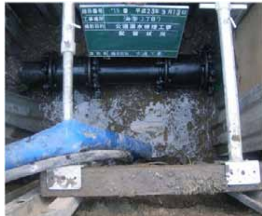
写真 3-11-4 修繕後の状況
