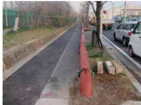
写真 3-12-18 仮設ポンプの設置によるバイパス機能の確保
