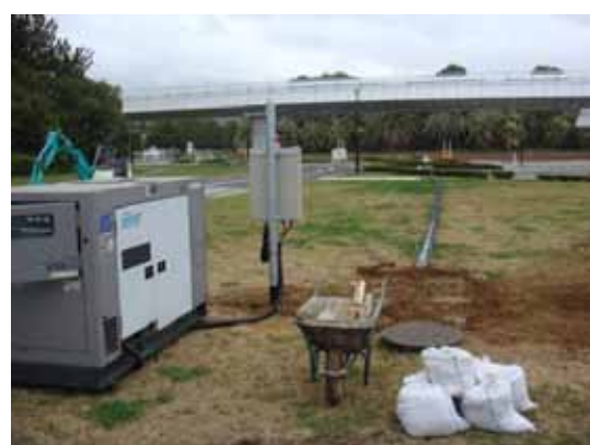
写真 3-12-16 応急仮復旧工事状況
