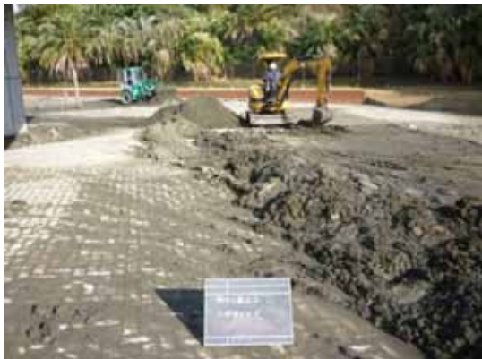
写真 3-12-13 応急措置及び応急復旧状況 (幕張海浜公園)
