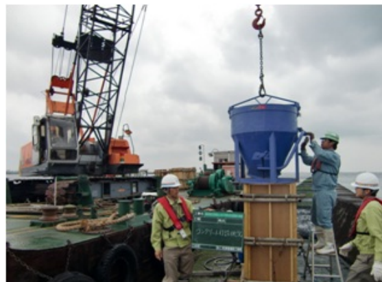
写真 3-12-12 防波堤 仮灯標施工状況
