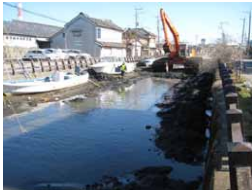
写真3-4-6 (一)小野川 河道掘削
