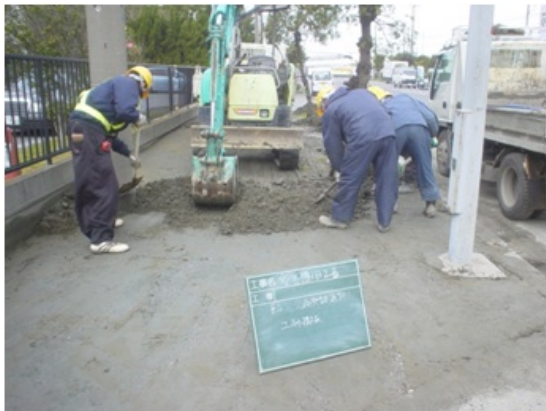
写真 3-12-9 臨港道路 土砂撤去
