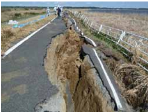
(一)北印旛沼 栄町酒直(2) 堤防の亀裂・沈下状況
