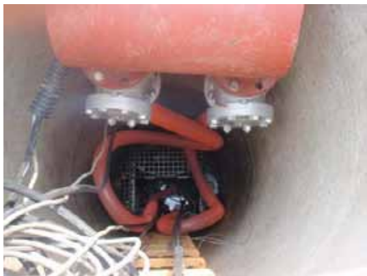
写真 3-12-17 仮設ポンプの設置によるバイパス機能の確保
