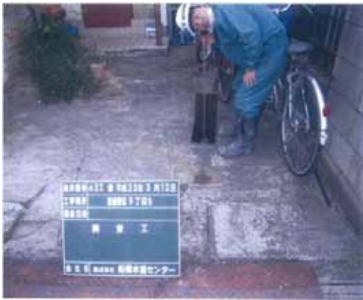
写真 3-11-1 漏水調査の状況
