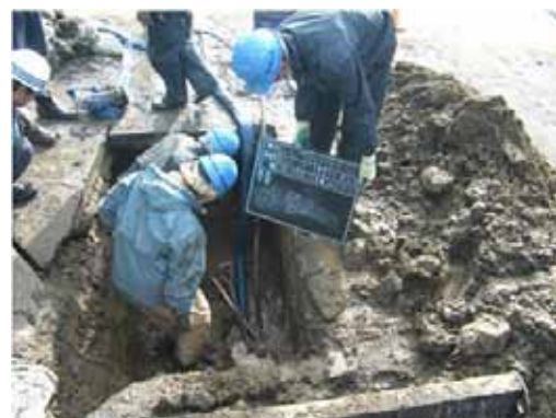
写真 3-11-6 応援復旧状況
