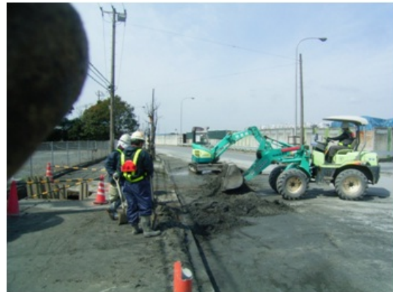
写真 3-12-10 臨港道路 土砂撤去
