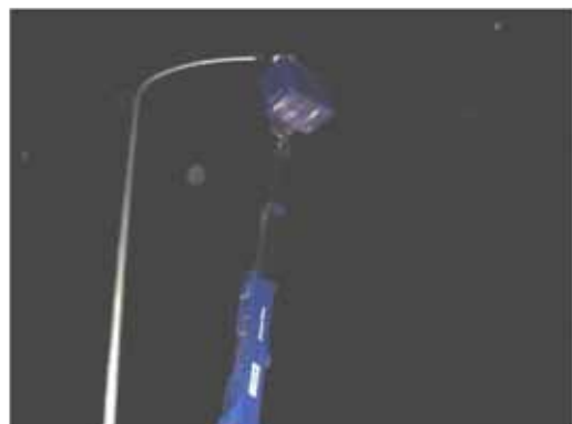
写真 3-4-11 (一)松戸三郷線 照明灯灯具撤去
