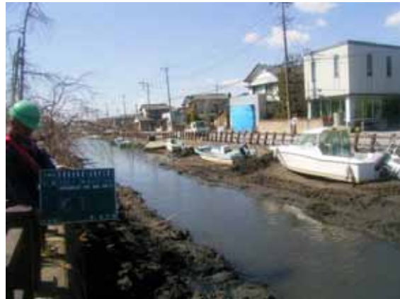
応急仮工事 大型土のう設置
