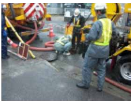
写真 3-12-20 高圧洗浄車による洗浄と バキューム車による吸引作業
