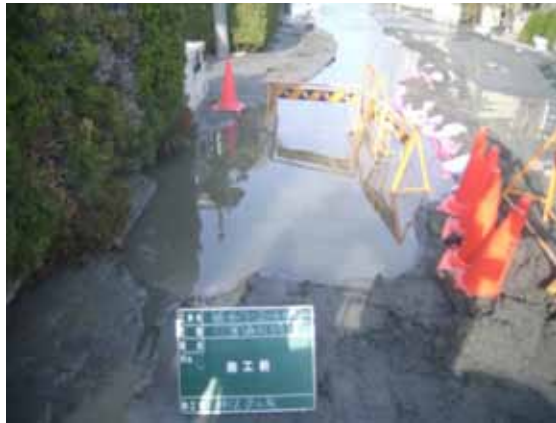
写真 3-11-2 漏水の状況
