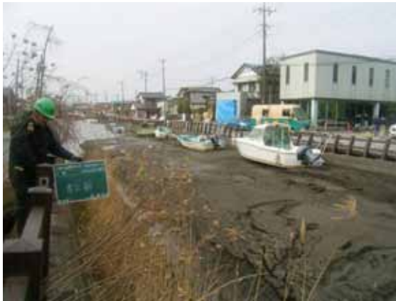
右岸護岸の倒壊状況
