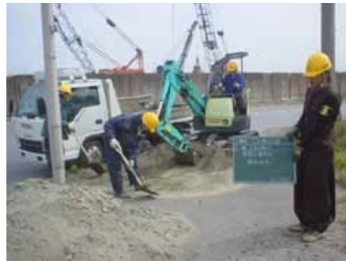
写真 3-4-1 土砂撤去 葛南港湾事務所
