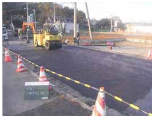
写真 3-4-2 (一)白井流山線 舗装工
