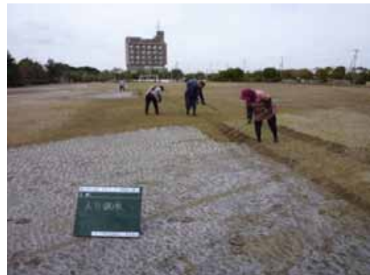
写真 3-12-14 応急措置及び応急復旧状況 (蓮沼海浜公園)
