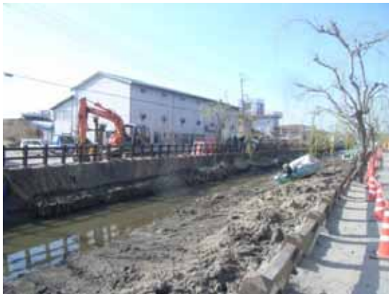
左岸護岸の倒壊状況
