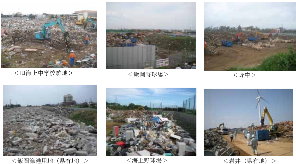
写真 3-18-2 仮置場の設置状況
