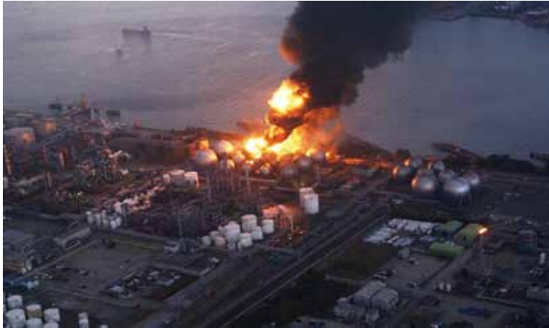
写真 2-1-15 コスモ石油(株) 千葉製油所 LPG タンク爆発 火災 (千葉市消防局提供)
