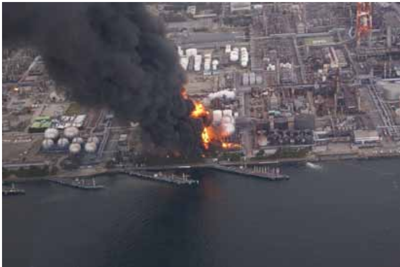
写真 2-1-16 コスモ石油(株) 千葉製油所 LPG タンク爆発 火災 (千葉市消防局提供)
