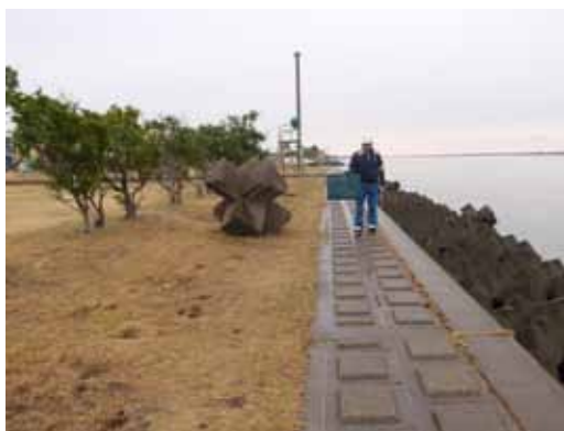
写真 2-2-2 打ち上げられた波消しブロック 河川遡上した津波の強さを示している。 (長塚町運動公園)
