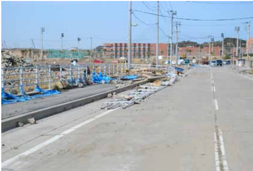
写真 2-2-21 津波による被害（銚子市潮見町：銚子市提供）
