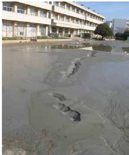
写真 2-3-13 千葉市美浜区高浜三小 大規模な亀裂に伴う噴砂と沈下でできた水たまり (3/12)
