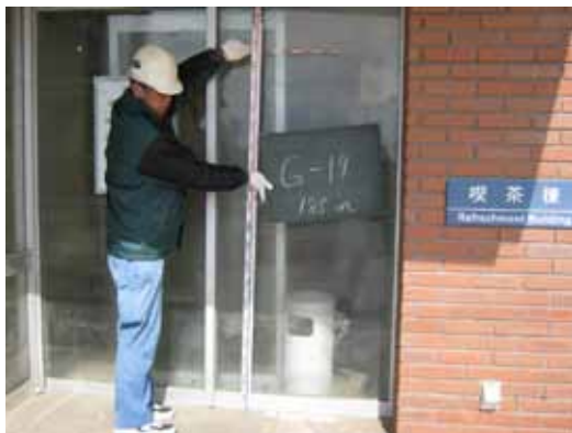
写真 2-2-7 浸水した喫茶棟 (千葉科学大学)
