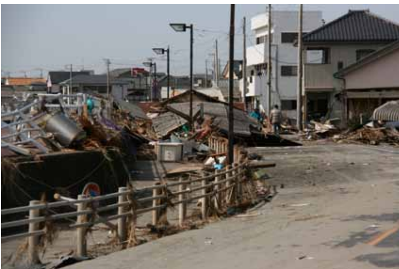
写真 2-2-23 津波による被害（旭市飯岡地域：旭市提供）
