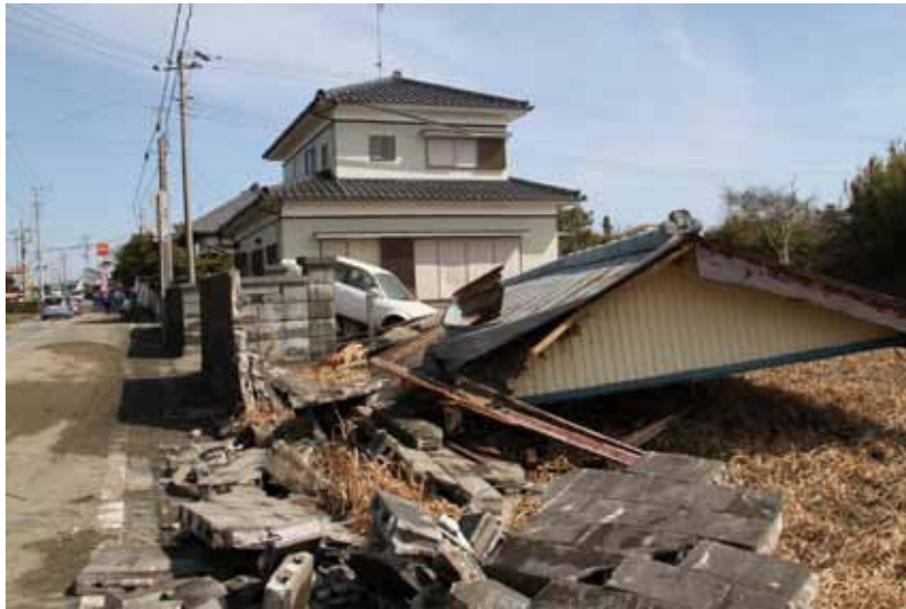
写真 2-2-27 津波による被害（木戸川周辺：山武市提供）
