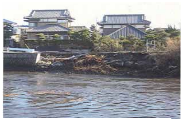
写真 2-1-4 河川被害(木戸川：山武市)
