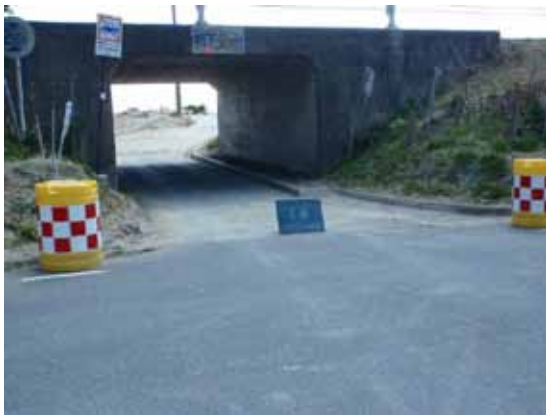
写真 2-2-17 有料道路下のトンネル 市街地への進入路となった（大網白里町）
