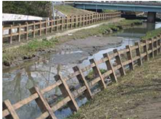
写真 2-3-24 香取市佐原口 十間川護岸のはらみ出しと河床の盛上り (3/19)
