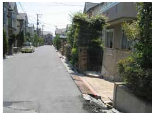
写真 2-3-6 浦安市舞浜 宅地部分が20cm程度沈下した。 レンガ塀も20cm程度沈み込んでいる。
