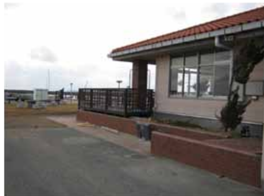
写真 2-2-8 浸水深 2.1m のセンターハウス正面 (海側) のガラスは全壊 (千葉科学大学)
