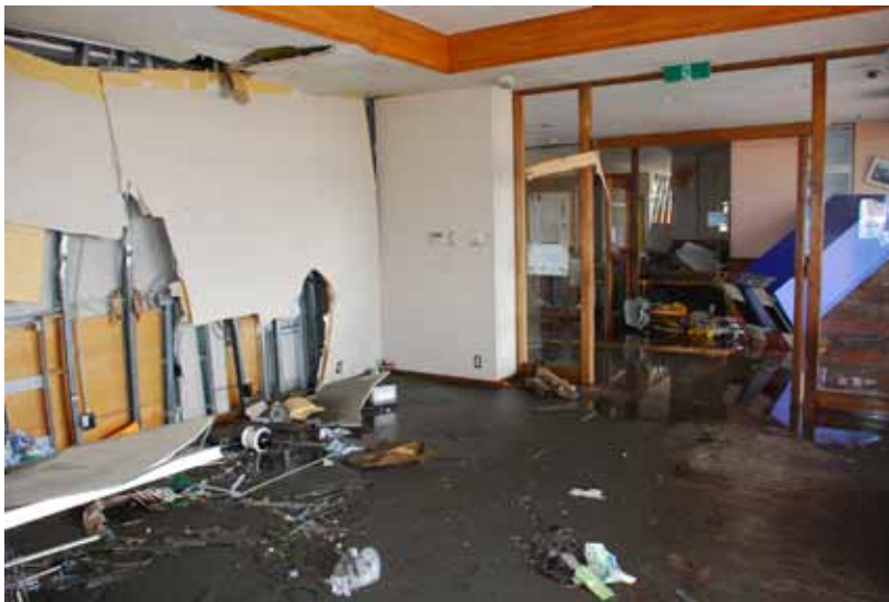
写真 2-2-22 津波による被害（銚子マリーナ：銚子市提供）
