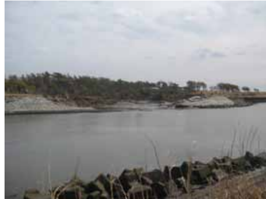
写真 2-2-16 木戸川の堤防の決壊 (山武市)
