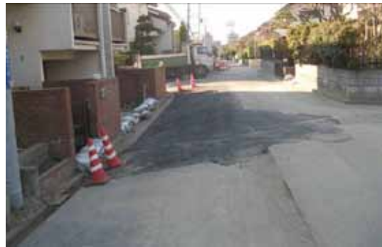
写真 2-3-17 千葉市美浜区磯辺 家屋が周辺とともに 0.6m 弱沈降した（3/28）
