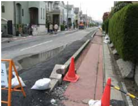
写真 2-3-2 浦安市舞浜 道路中央が相対的に高くなり、両脇が数十cm沈下している。 両脇の戸建て住宅とレンガ塀は数十cm程度沈み込んでいる。
