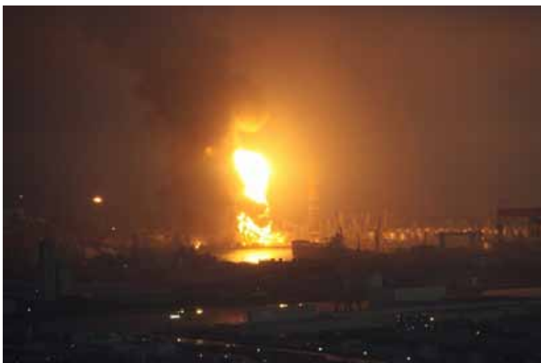
写真 2-1-17 コスモ石油(株) 千葉製油所 LPG タンク爆発 火災 (千葉市消防局提供)
