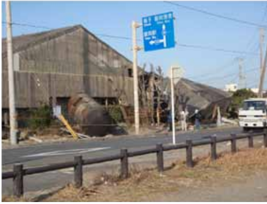
写真 2-2-11 倒壊した工場倉庫とタンク (旭市萩園)
