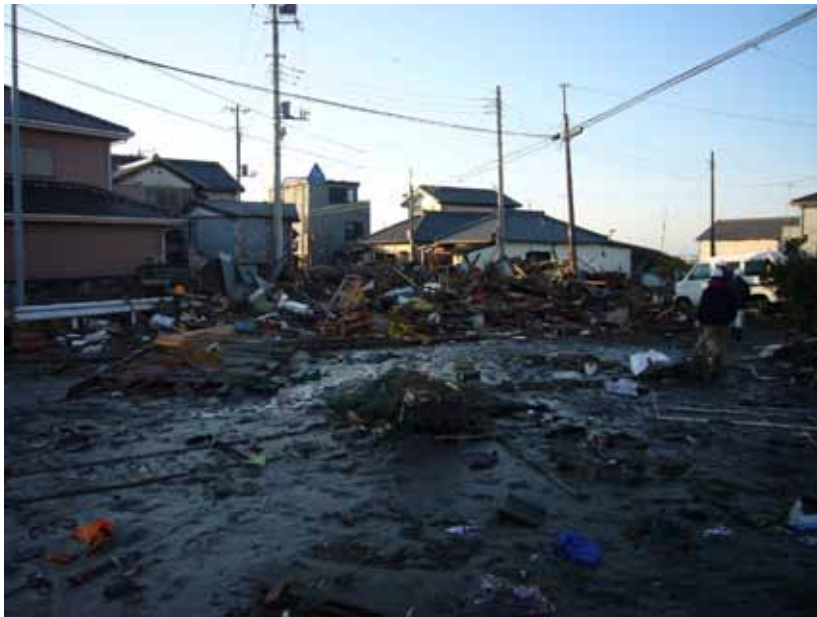
写真 2-2-24 津波による被害（旭市飯岡地域：旭市提供）
