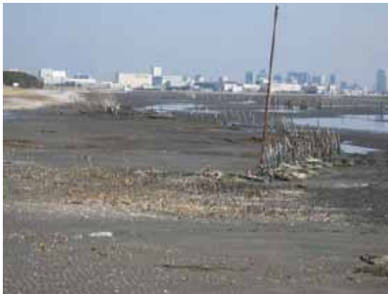
写真 2-1-33 震災後の野球場 中央の立木が枯れ、傾斜した地盤となった。
