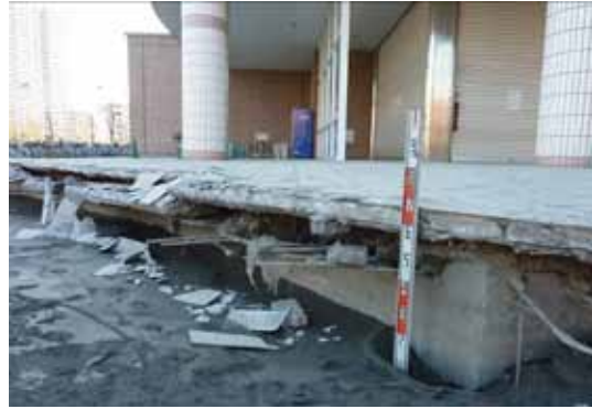
写真 2-3-15 浦安市明海 噴砂と沈下による抜け上がり（3月中旬）
