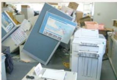
ロッカー等の転倒 (千葉県庁本庁舎)
