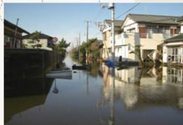
津波による被害 (横芝光町)
