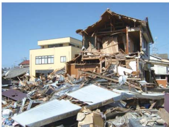
津波により倒壊した木造家屋(旭市飯岡)
