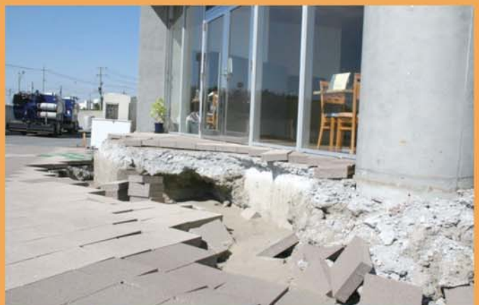
建物の抜け上がり（アクアリンクちば：千葉市）
