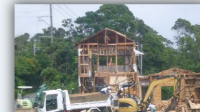
〔公費解体中の現場〕
