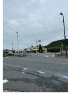
出入口①の状況 道路向かい側から
