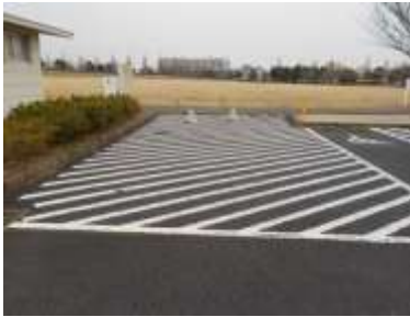
施設への出入口の状況
