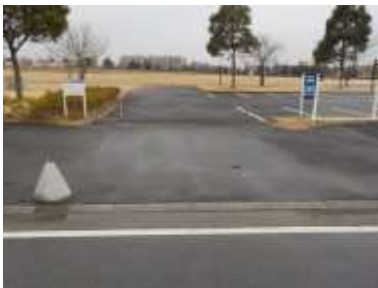
施設への出入口の状況
