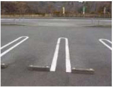
施設への出入口の状況
