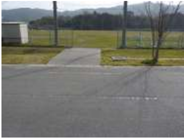
施設への出入口の状況
