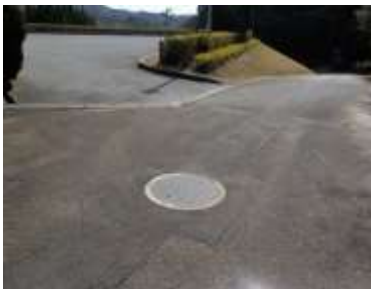
施設への出入口の状況
