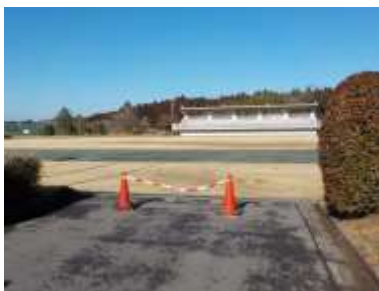
施設への出入口の状況
