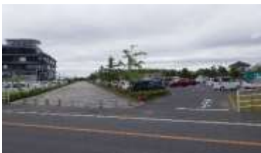
施設への出入口の状況
