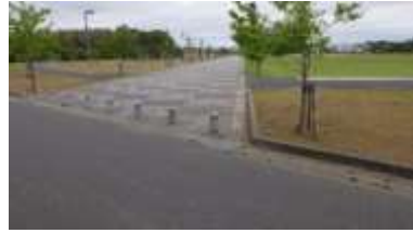
出入口②の状況 2車線分の道路幅がある
