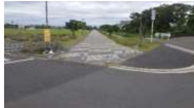
出入口④の状況 2車線分の道路幅がある
