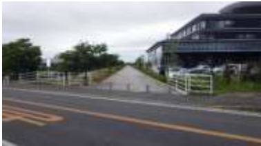
出入口③の状況 2車線分の道路幅がある
