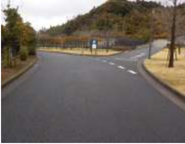
施設への出入口の状況
