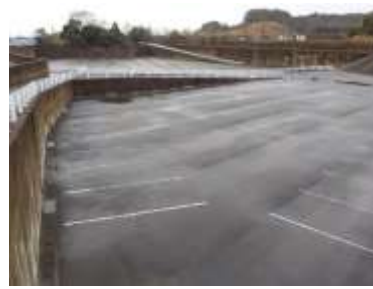
施設内広場等の状況
