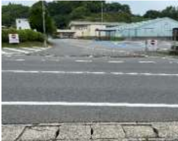
施設への出入口の状況
