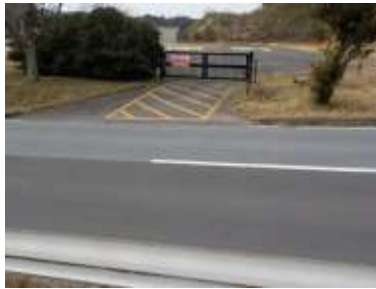
施設への出入口の状況 ※ヘリポート入口から陸上競技場へは進入不可
