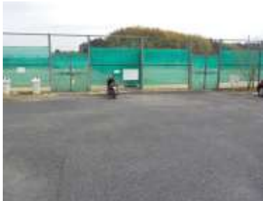
施設への出入口の状況
