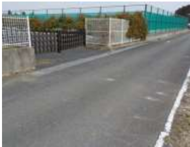
施設への出入口の状況
