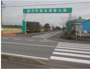
出入口①の状況 2車線分の道路幅がある
