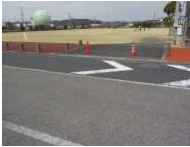
施設への出入口の状況
