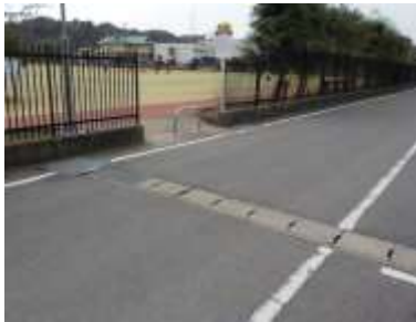
出入口③の状況 1車線分の道路幅があるが、多目的広場 への進入にあたっては段差がある
