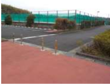
施設への出入口の状況
