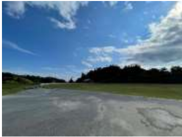
施設への出入口の状況
