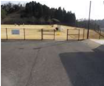
施設への出入口の状況
