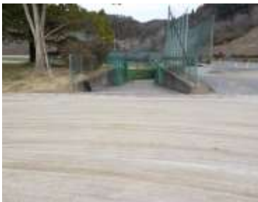
施設への出入口の状況
