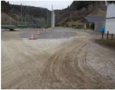
施設への出入口の状況
