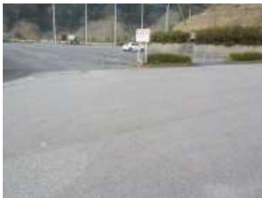
施設への出入口の状況
