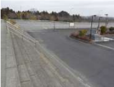
施設への出入口の状況
