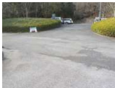
施設への出入口の状況
