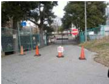
出入口⑤状況 2車線分の道路幅がある
