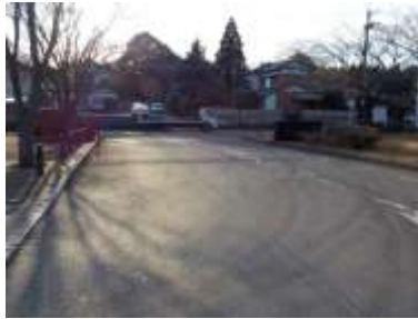
施設への出入口の状況
