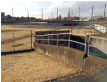
施設への出入口の状況
