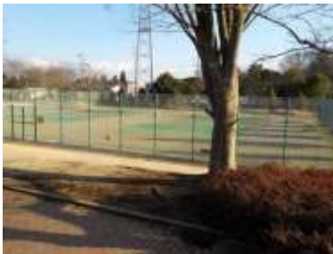
施設への出入口の状況
