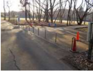
施設への出入口の状況
