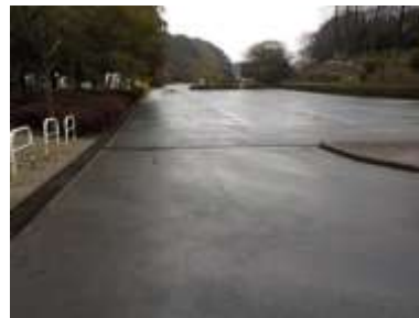
施設内広場等の状況
