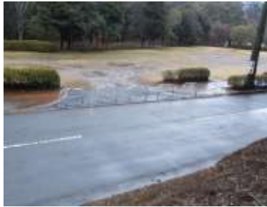
施設への出入口の状況
