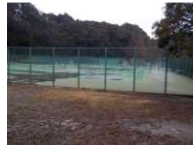
施設内広場等の状況
