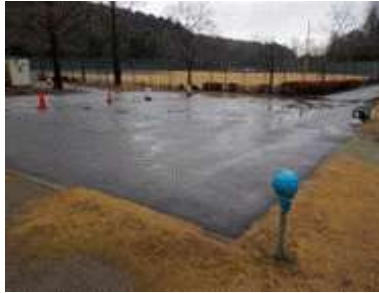
施設への出入口の状況
