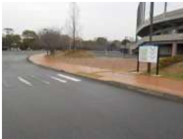
施設への出入口の状況
