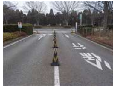
出入口⑤の状況 3車線分の道路幅がある
