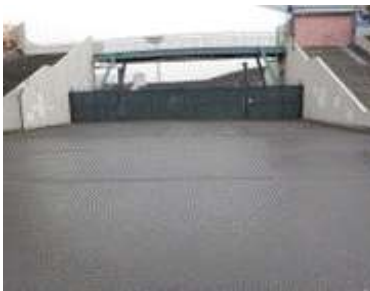
施設への出入口の状況
