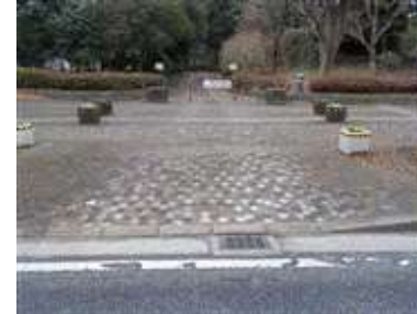
出入口⑥の状況 3車線分の道路幅がある
