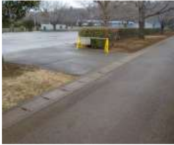
施設への出入口の状況
