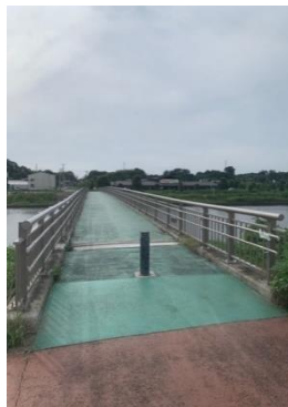
(ふるさとステーション側から見た連絡橋)
