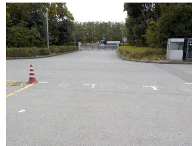
出入口⑥の状況 3車線分の道路幅がある
