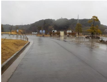
施設への出入口の状況
