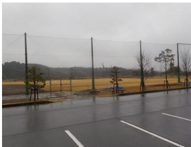
施設への出入口の状況
